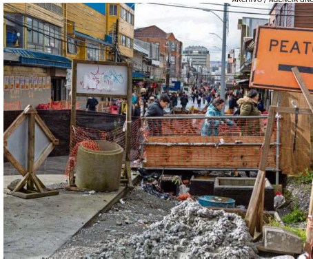
PAREDES ENUMERÓ ACCIONES A LA ESPERA DE TERMINAR LOS TRABAJOS.
