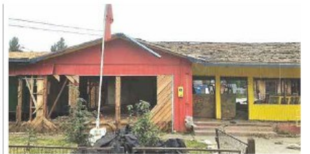
Se está demoliendo la actual infraestructura.
